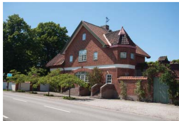
Figur 4.5 Den fd stationsbyggnaden.
