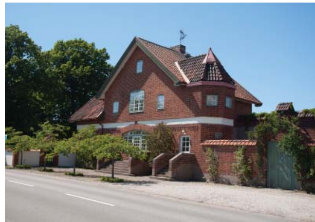
Figur 4.5 Den fd stationsbyggnaden.
