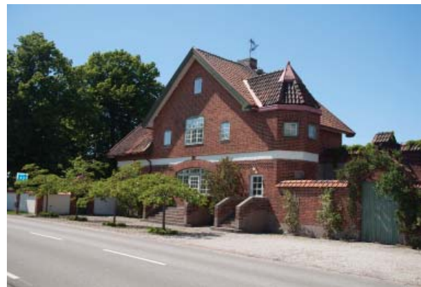
Figur 4.5 Den fd stationsbyggnaden.
