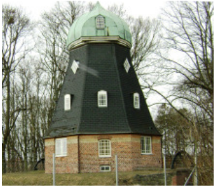
Brågarps mölla (6) Troligen uppförd 1850-tal. Har bl a använts som möteslokal.
