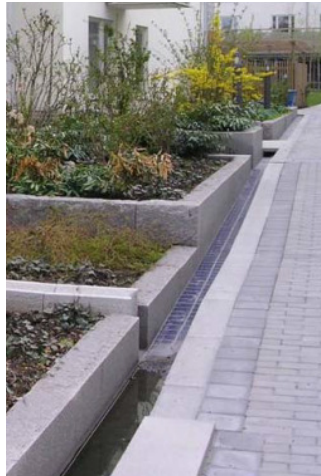
Exempel stensatt kanal
