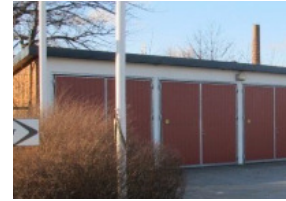
Garage (13) Uppfört 1970-tal.
