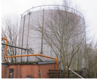
Cistern (7) Uppförd 1940-tal för lagring av olja.
