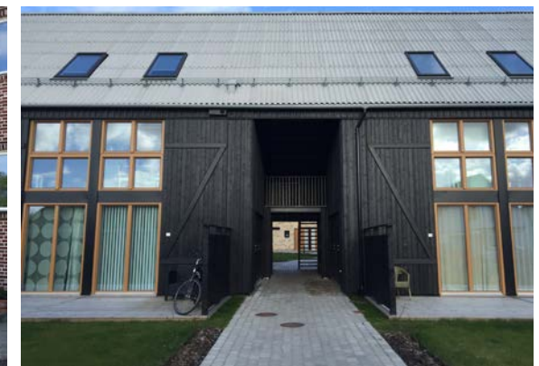
Omvandling av den befintliga bebyggelsen
