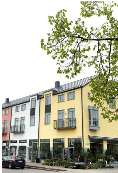
En mångfald av taklutningar
