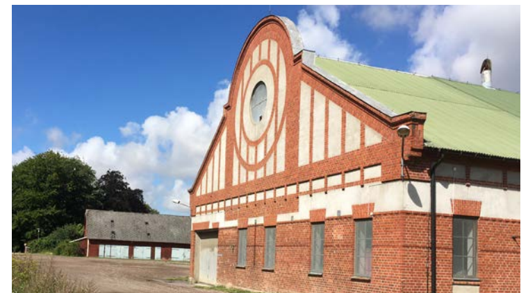
Den befintliga stallbyggnaden
