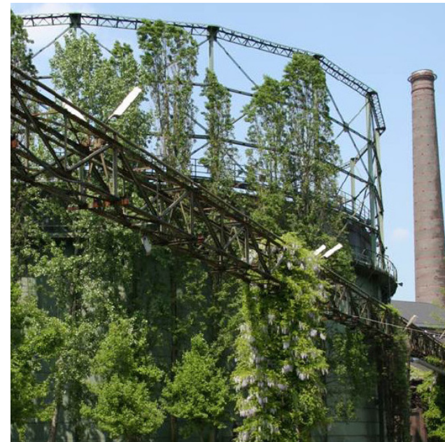
Ny stålkonstruktion som knyter an till siloformen
