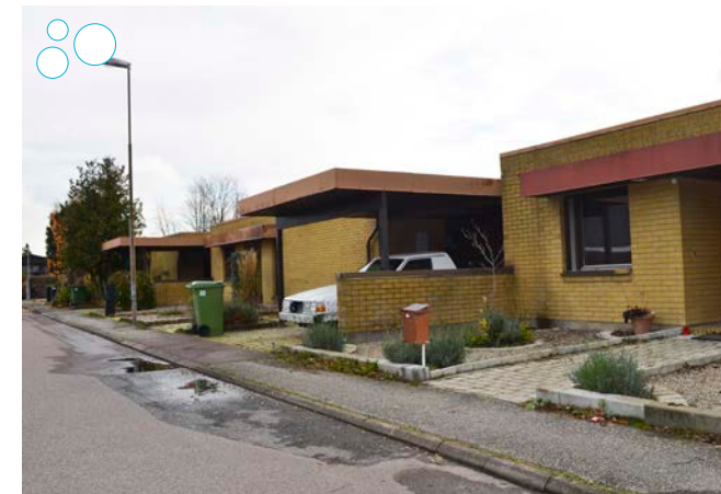
Atriumhus vid Långdansvägen och Ringdansvägen, Polonäsbyn
