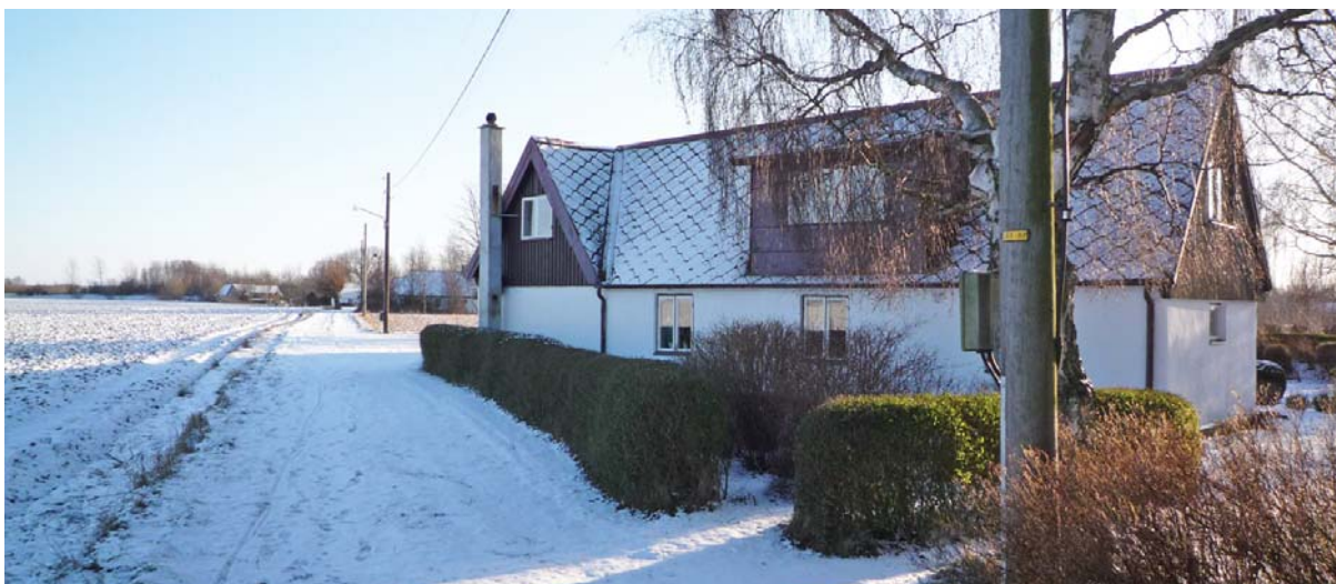
Bild: Hus vid Vikhemsvägen, norra delen. Vy mot sydost.
