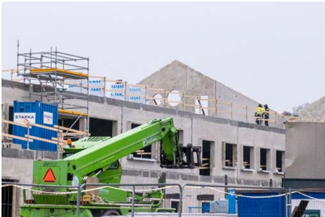
Nya Stanstorpsskolan beräknas stå färdig sommaren 2026.
