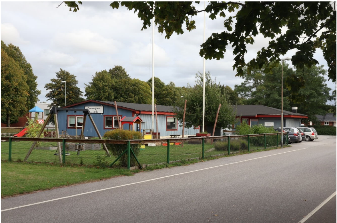
Bild 2 Domsagans förskola sedd från Domsagovägen med vy mot sydväst
