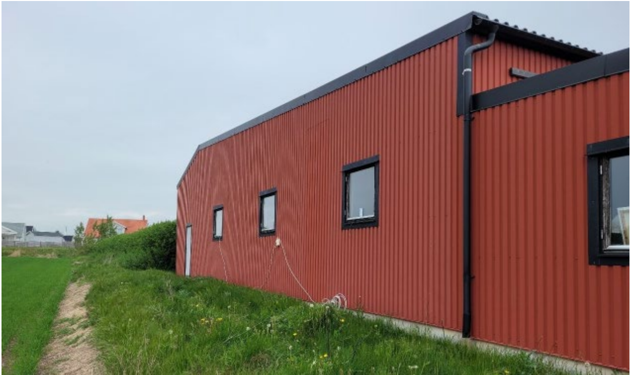
Senare tillbyggnad mot söder. Utdrag ur Kulturmiljöutredningen. Foto Tyrens.
