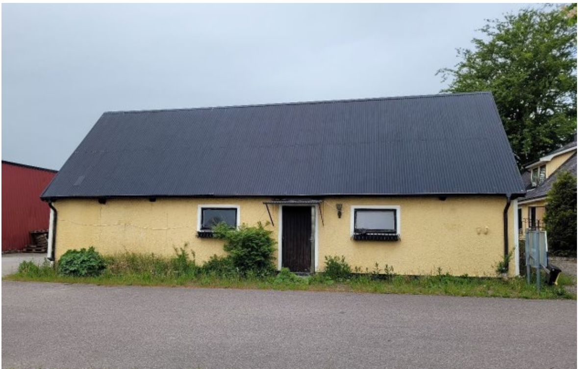
Östra uthuslängan, fasad mot öst. Utdrag ur Kulturmiljöutredningen. Foto Tyrens.
