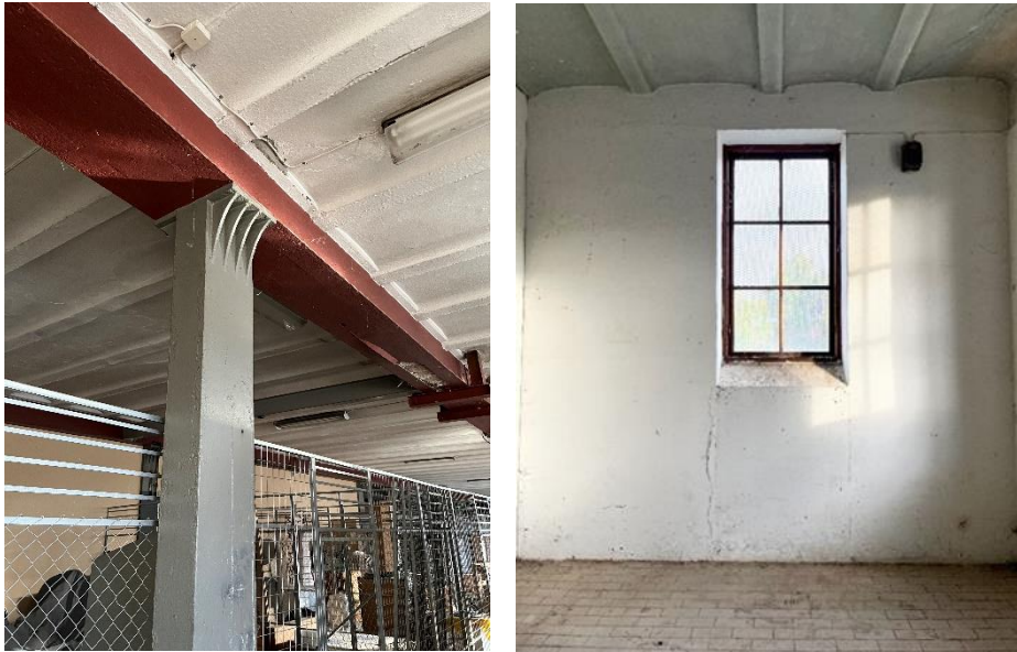
Figur 37-38 Stallets stålbalkar och bremervälv samt ekfönster
