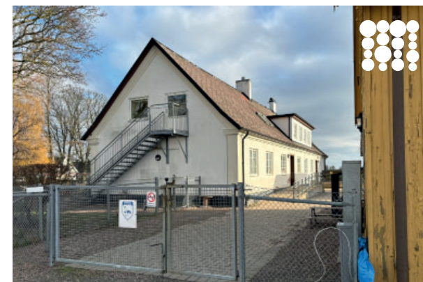
Gård, Görshögsvägen 9, Nordanå 8:4 ca 1850 (mangårdsbyggnad), Duvemåla Gård
