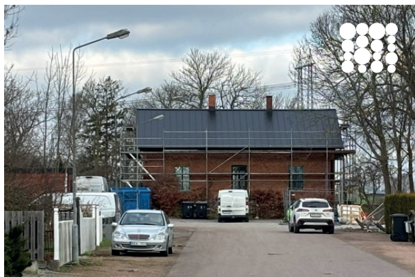
Stationsbyggnad, Stationsvägen 18, Nordanå 2:6 1892
