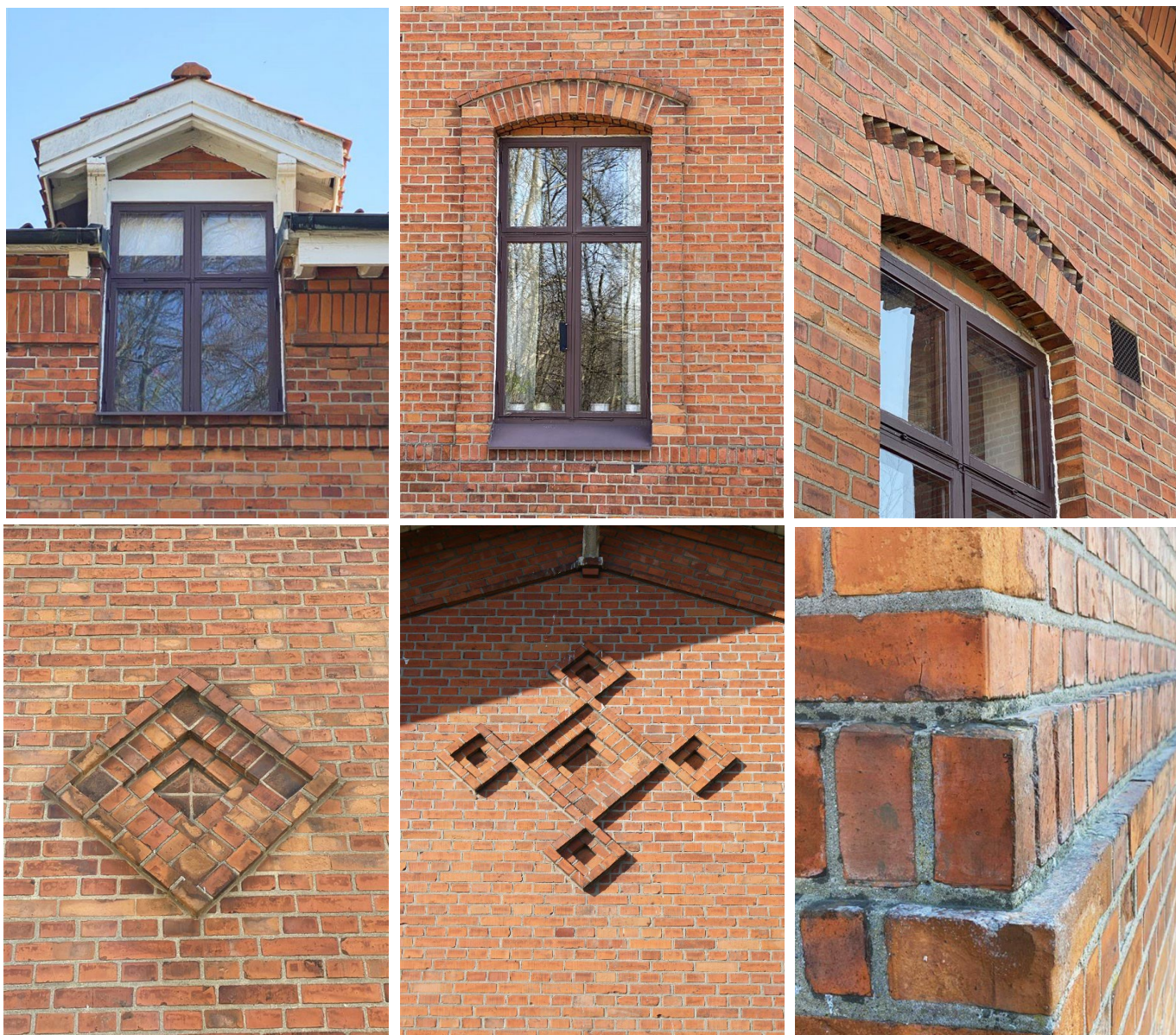
Figur 9: Detaljer i Södra villans fasad.
